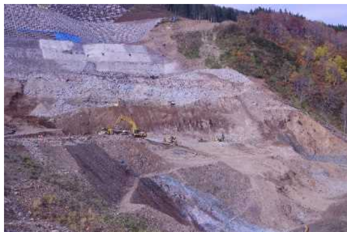
排土工の施工状況 (他ダム事例)
