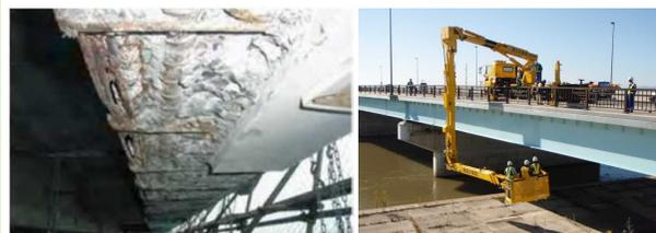
【塩害等による橋梁の鉄筋腐食】
