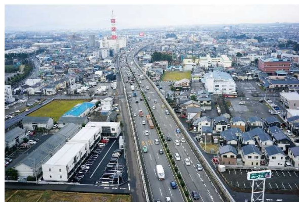
図8 アクセスコントロールされた立体構造である国道8号新潟バイパス
