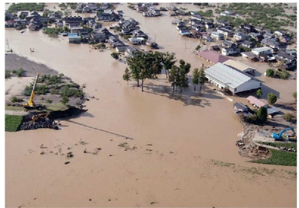
図11 令和元年東日本台風で発生した千曲川の堤防決壊（長野市穂保地区）
