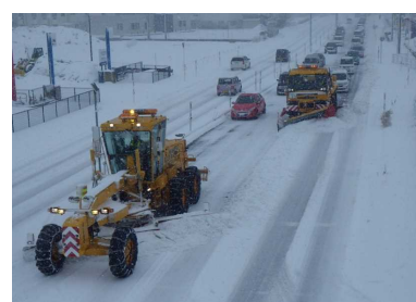
図 22 冬期の交通ネットワークを確保する除雪作業(国道8号 新潟県上越市)
