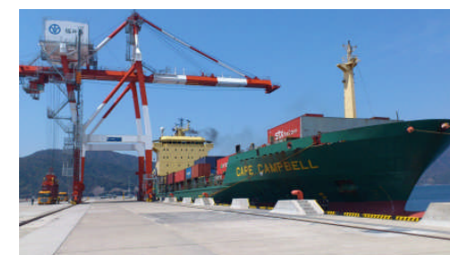
敦賀港における国際物流ターミナルの整備推進
