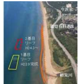
押水羽咋海岸侵食対策事業 (千里浜海岸・石川県)
