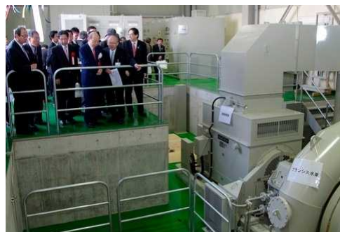
竣工した山田新田用水発電所(富山県南砺市)
