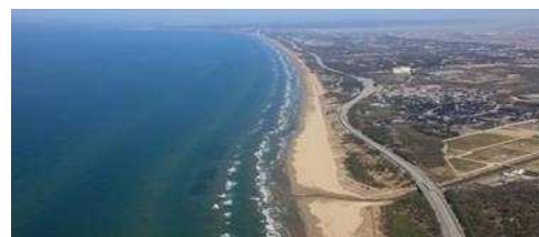
押水羽咋海岸侵食対策事業 (千里浜海岸・石川県)
