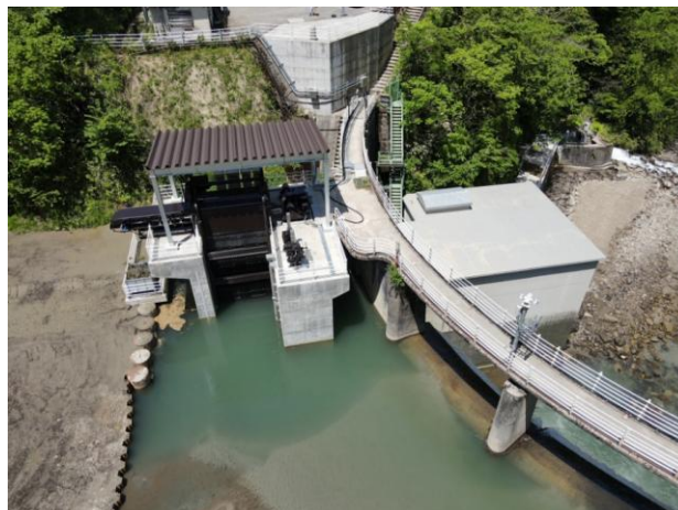
[若土発電所の全景]
