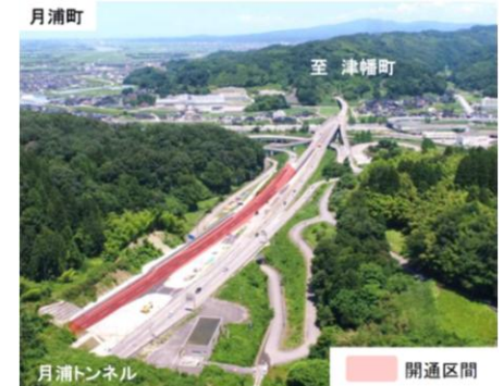
出典：国道159号金沢東部環状道路(月浦町～神谷内町)4車線化開通(令和5年8月4日、記者発表資料)、金沢河川国道事務所
