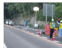
通行規制箇所 交通コントロール
