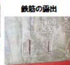
下部工にASRによる劣化が疑われる
