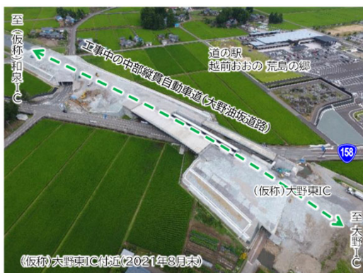
〔(仮称)大野東IC付近の工事の状況〕
