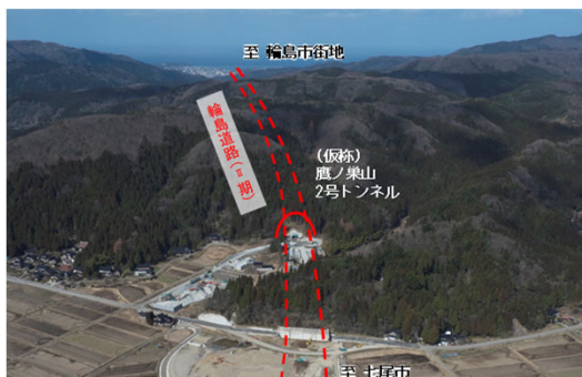
〔能越自動車道：輪島道路（Ⅱ期）〕
