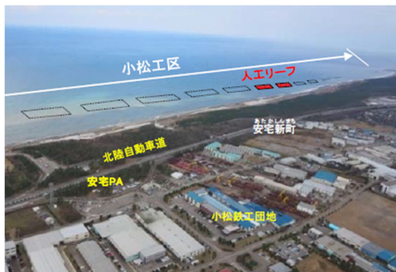
【石川海岸直轄海岸保全施設整備(小松工区)】
