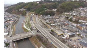
【出典】北陸地方整備局 金沢市内で進められている環状道路整備
