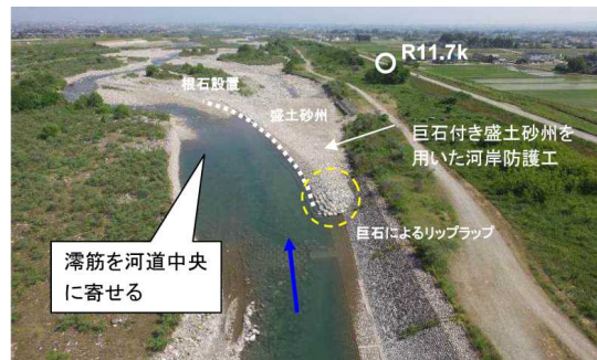
巨石付き盛土砂州を用いた河岸防護工
