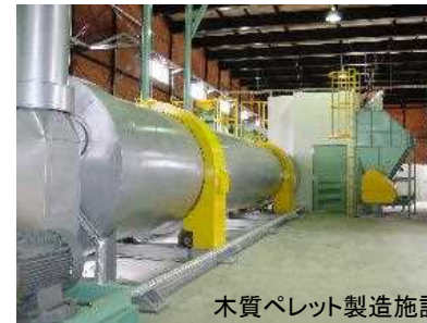
木質ペレット製造施設【出典】富山市HP
