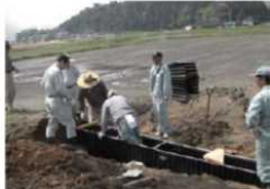
水田魚道の設置
