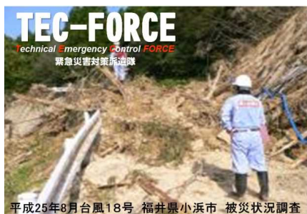
平成25年8月台風18号 福井県小浜市 被災状況調査
