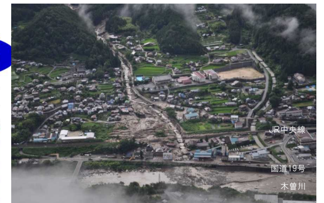
平成26年南木曾町梨子沢土石流(土砂被害)
