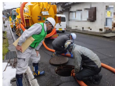
【農業集落排水施設の点検】
