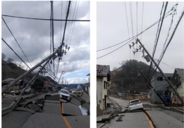
出典:令和6年能登半島地震の電力・ガスにおける復旧対応等について(経済産業省)
