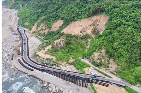
〔国道249号:迂回路整備(輪島市)〕
