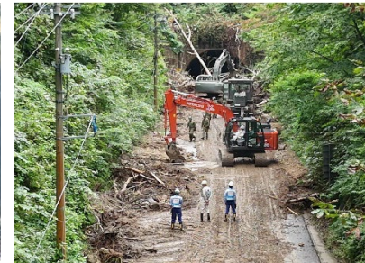
【珠洲市道の道路啓開】
