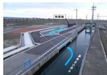
[用水からの取水口]
