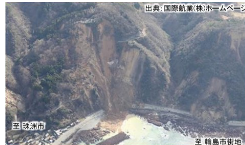
【国道249号沿岸部の大規模土砂崩れ】
