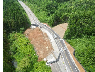
〔能越道:緊急復旧(穴水町)〕
