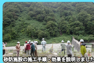
砂防施設の施工手順・効果を説明しました
