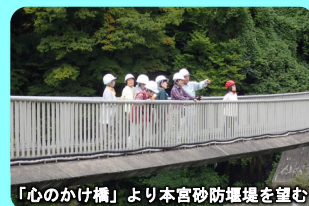
「心のかけ橋」より本宮砂防堰堤を望む
