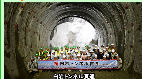
白岩トンネル貫通
