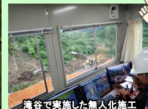
滝谷で実施した無人化施工
