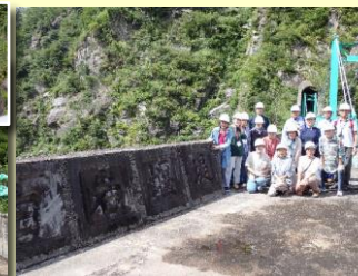
7基の副堰堤を合わせた 高さ108mは日本一
