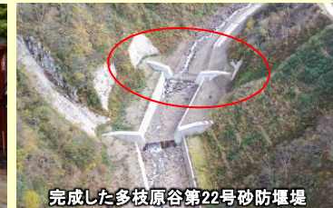
完成した多枝原谷第22号砂防堰堤
