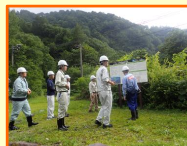
白岩砂防堰堤
