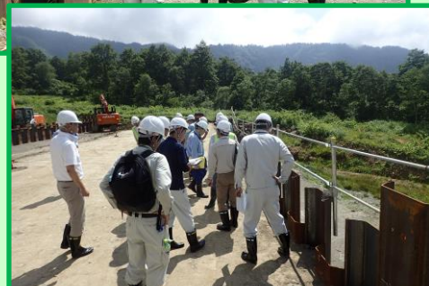
砂防工事現場にて意見交換 協力会社: 辻建設(株) 【工事名: R6 金山谷基幹砂防堰堤工事】
