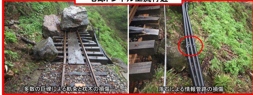
七郎トンネル上流付近
