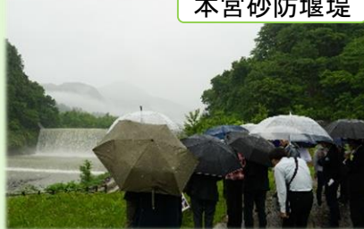
本宮砂防堰堤
