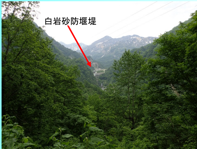
【白岩砂防堰堤】鬼ヶ城連絡所～樺平連絡所間
