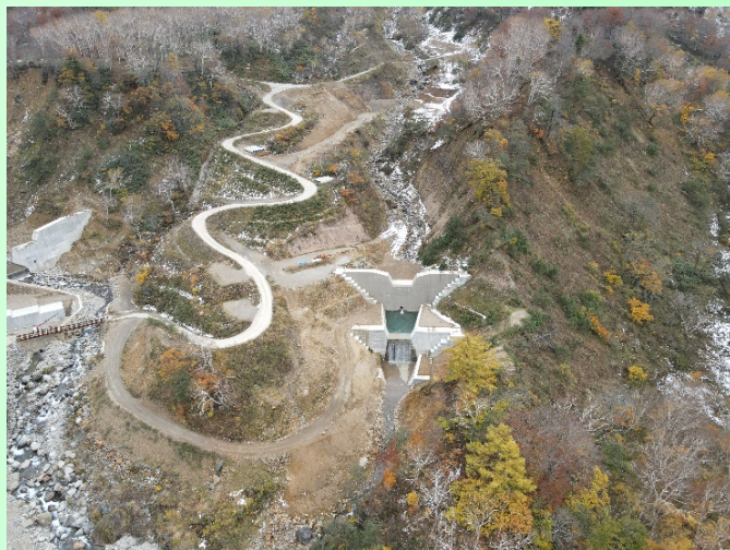
滝谷第1号砂防堰堤 竣工
