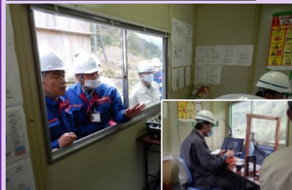
ICT施工現場(有峰二の谷)
