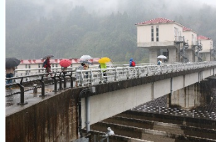
横江頭首工を見学
