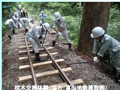
枕木交換体験(協力:富山地鉄建設㈱)
