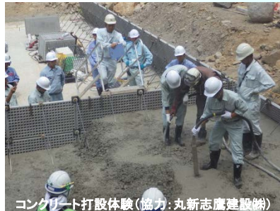
コンクリート打設体験(協力:丸新志鷹建設㈱)
