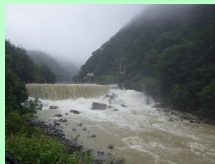
8. 8出水後の状況
