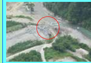
渡河施設の流出（真川・スゴ谷合流点）
