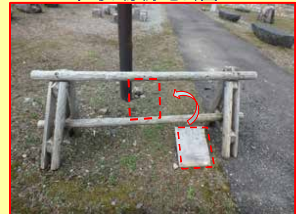
注意喚起看板を再設置すべき箇所
