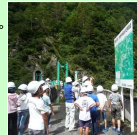
重要文化財 白岩砂防堰堤を見学 『うわー、高い』
