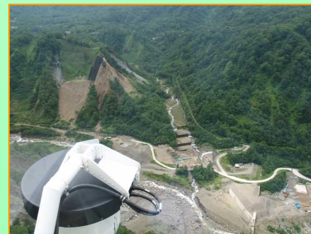
立山カルデラ内の状況 (多枝原谷合流点)
