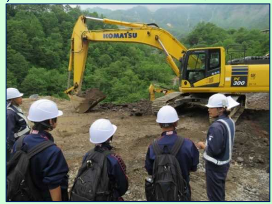
【(株)干場建設 多枝原谷下流砂防工事用道路その他工事】
