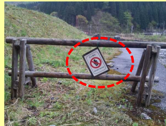
注意喚起看板を再設置すべき箇所
