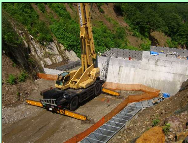
滝谷第1号砂防堰堤工事現場
