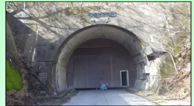
有峰トンネルの抗口の閉鎖
