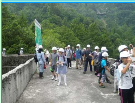
砂防現場を見学
