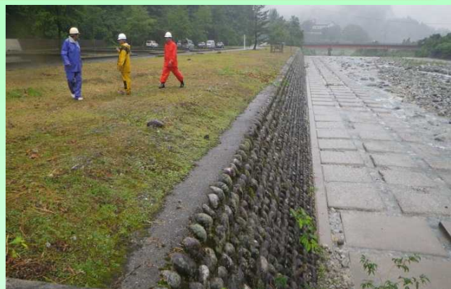
転落の危険性のため立入禁止ロープ設置 (立山1号公園:立山町藤橋上流側)
