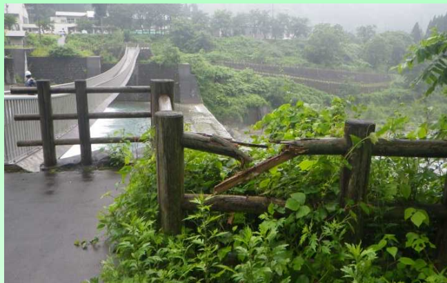
木製手摺りが破損しており補修 (常願寺川水辺の楽校:立山町芦峯寺)
