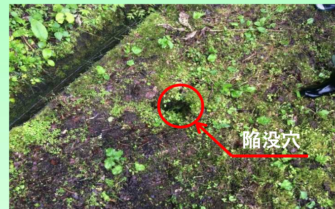
公園内の陥没穴を補修 (立山1号公園:立山町藤橋下流側)
