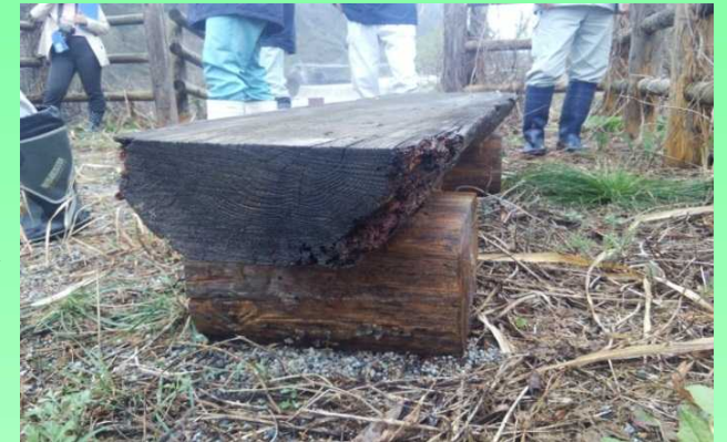
木製ベンチが不安定であり補修 (常願寺川水辺の楽校: 富山市小見滝見台)
