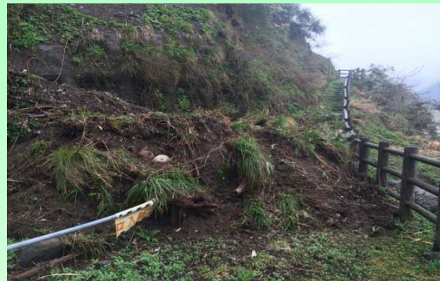
斜面崩壊のため進入禁止柵を設置 (常願寺川水辺の楽校: 立山町側斜面)
