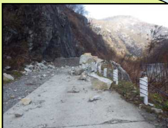
スゴ谷線岩盤崩落現場
