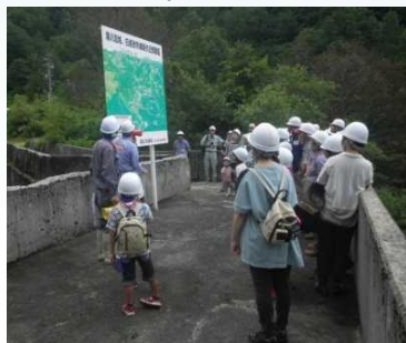
重要文化財「白岩砂防堰堤」高さ108mは凄い！
