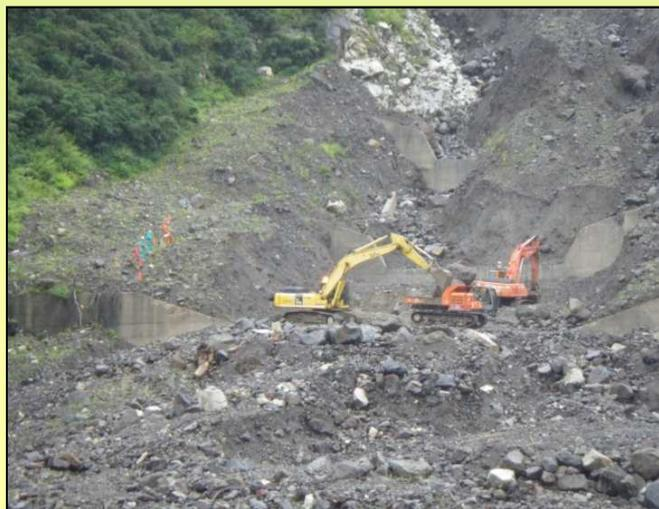
平成25年度工事で新たに導入された無人バックホウ(無人化施工)
