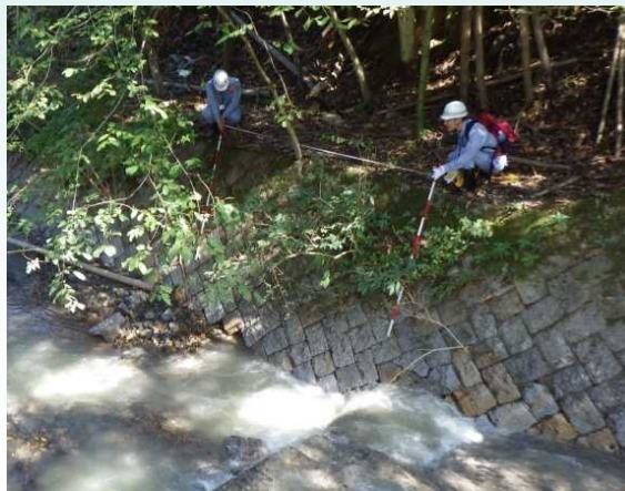
小浜市 松永川溪流 被害状況調査
