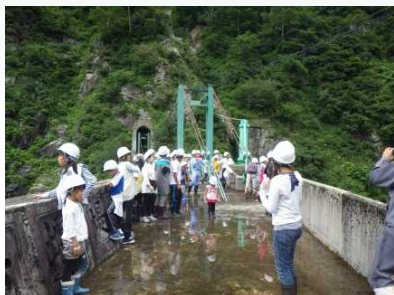
国の重要文化財「白岩砂防堰堤」へ
