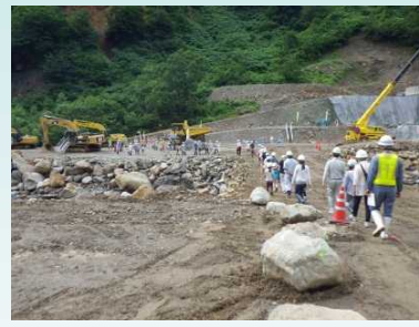
湯川第13号砂防堰堤工事現場見学
