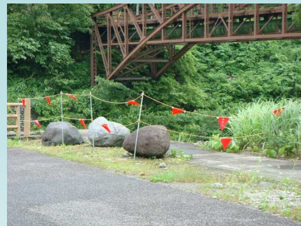
砂防堰堤天端へ繋がる開口部に立ち入り防止措置済み(鉄ピン、トラロープ) (千寿ヶ原緑地公園)
