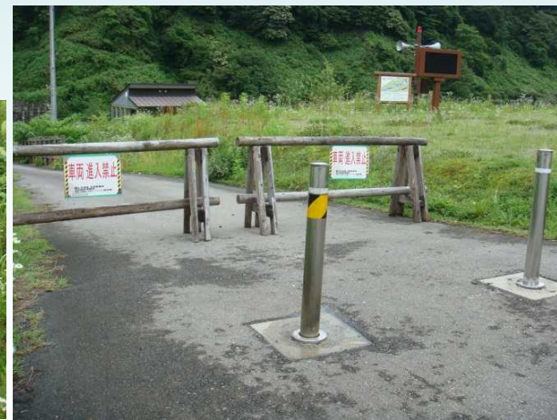
園路出入り口部の車両進入防止柵等の修繕済み(本宮水辺の楽校)
