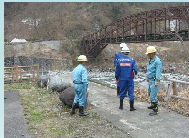
砂防堰堤天端へ繋がる開口部に立ち入り防止措置(鉄ピン、トラロープ) (千寿ヶ原緑地公園)
