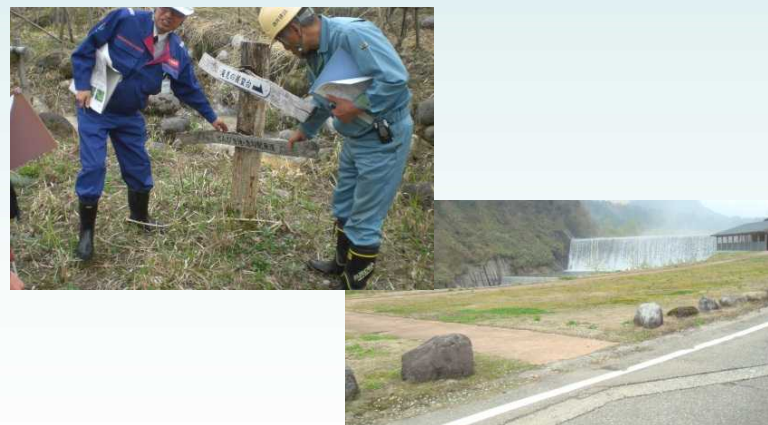
案内板が積雪により破損し補修。 園路出入り口部に車輛進入防止措置を追加 (常願寺川水辺の楽校)
