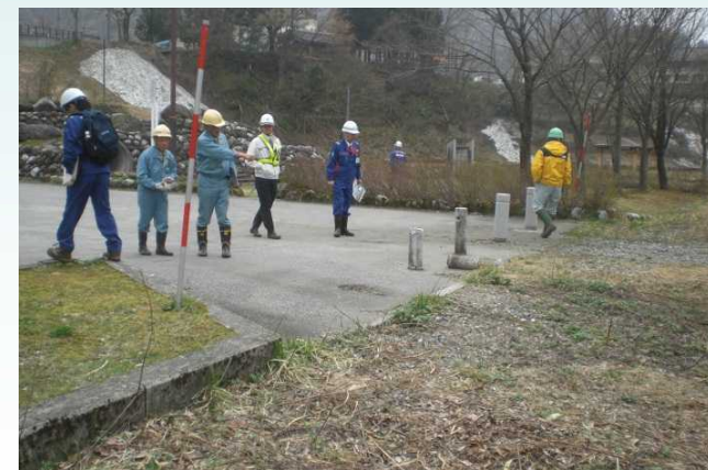
車止め損傷箇所に車輛進入防止措置を追加 (立山1号公園)
