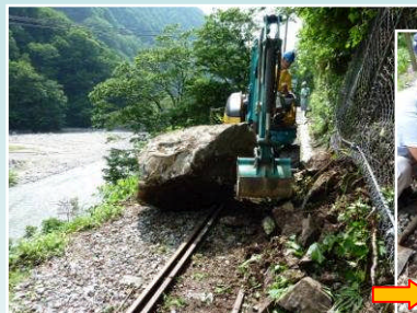
落石除去作業(ワサビ谷付近)
