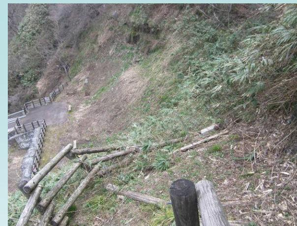
散策路木柵の支柱基礎が積雪により転落。
