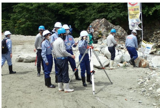
測量機器現場実習
