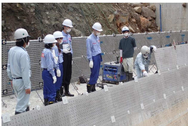
砂防堰堤工事現場見学
